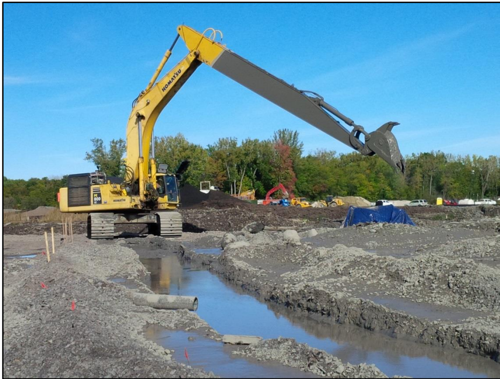
Creusage de la tranchée pour l'installation de la barrière à faible perméabilité
